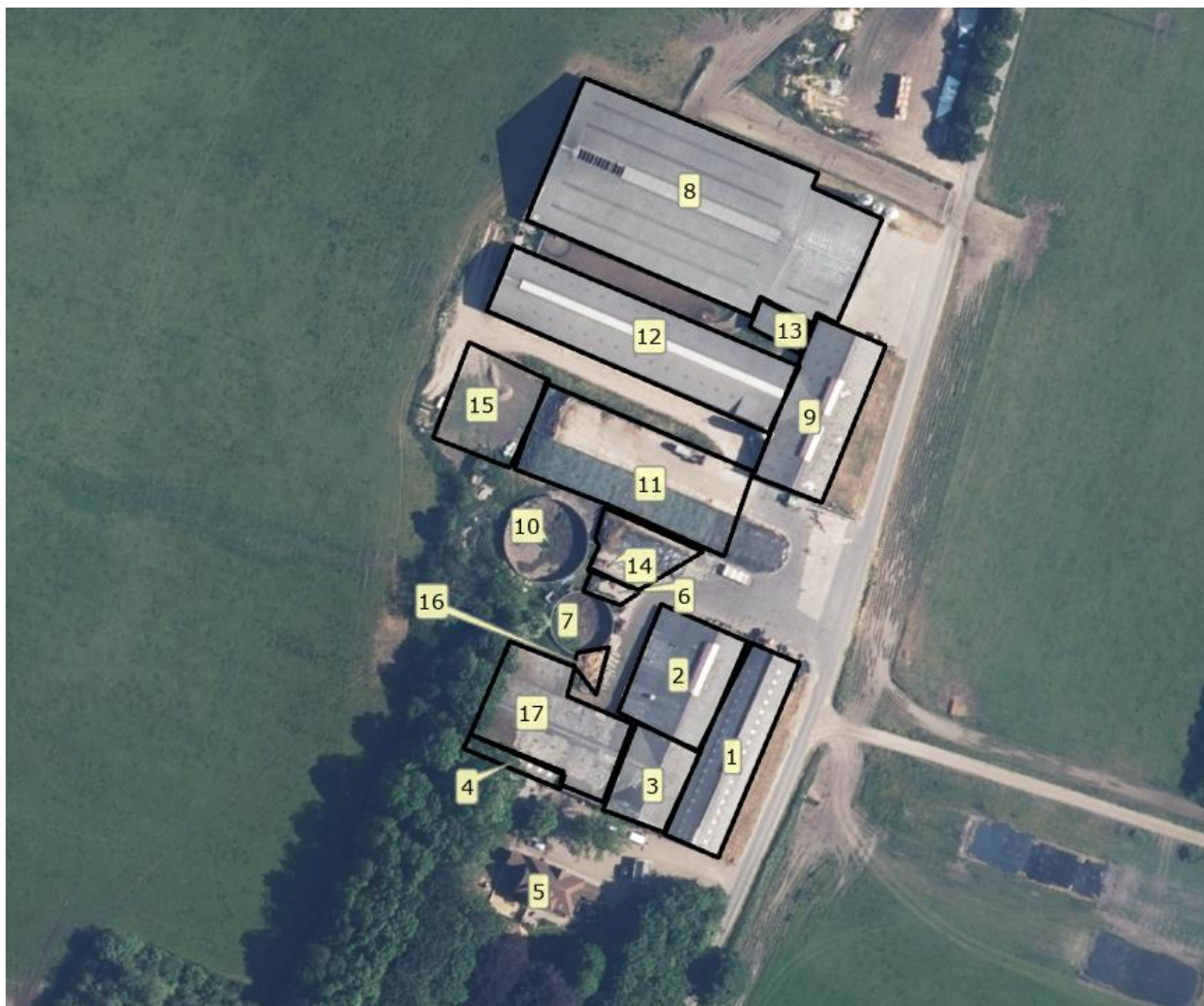
Figur 3 Oversigt over husdyrbrugets bygninger.
