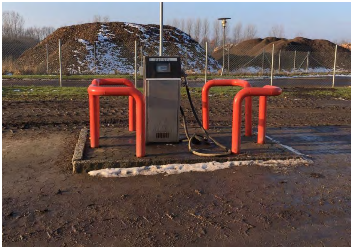
Figur 1 Tankstander. Området er belagt med SF sten
