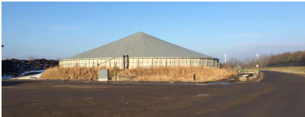
Figur 14 Perkolatbeholder, 5.000 m 3 – (2).
