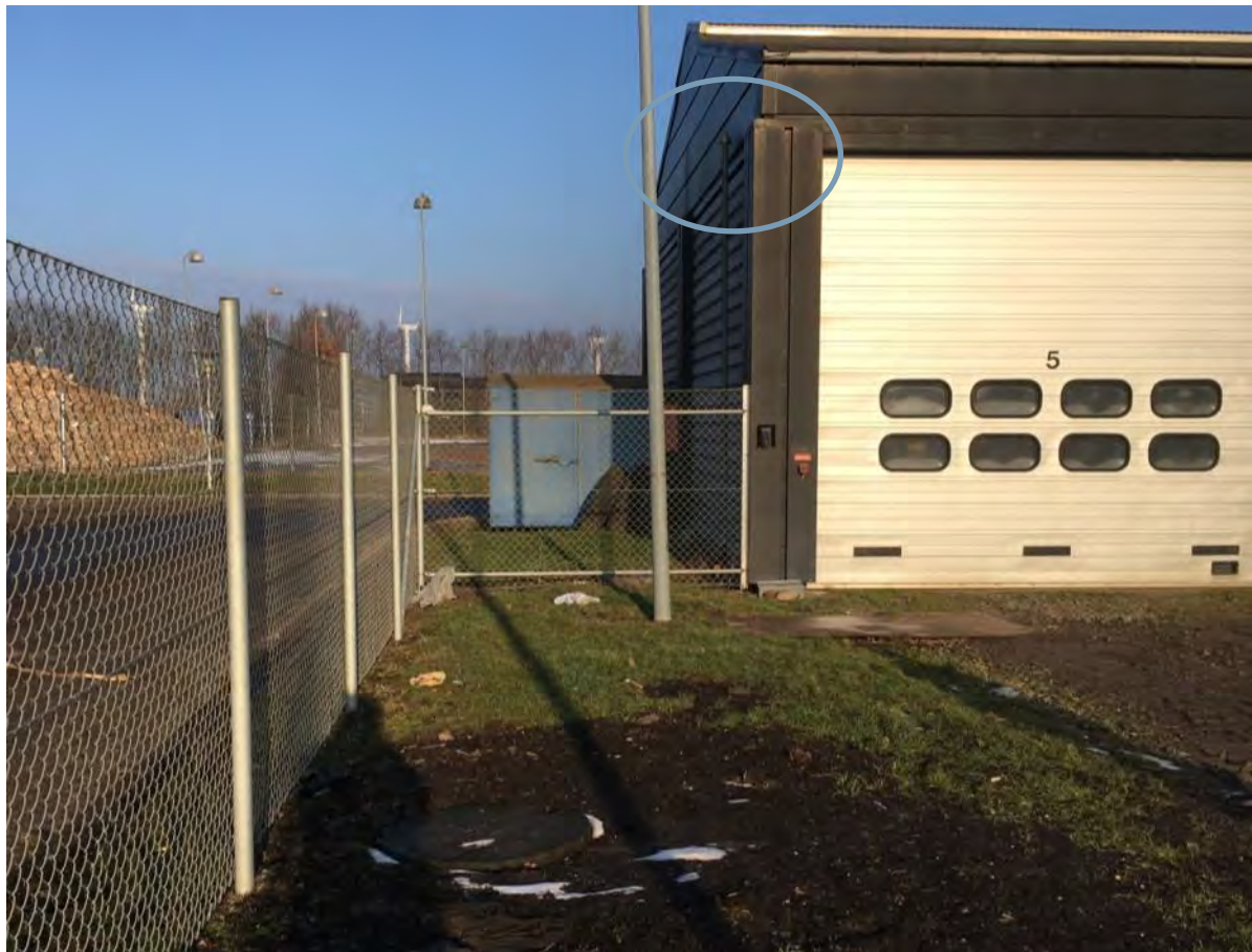
Figur 2. Område for nedgravet olietank. Udluftningen fra tanken ses ved gavlen (blå cirkel)
