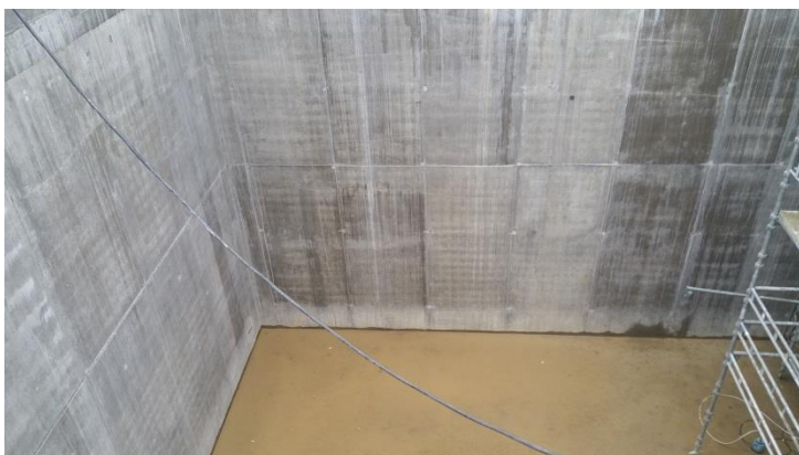
Den nye affaldsgrube under etablering
