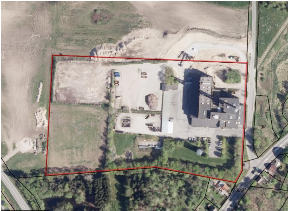
Luftfoto af Aars Fjernvarme Amba, sommeren 2018. Ny silobygning er i november 2018 under etablering i nordlig retning
