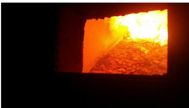
Ovn 2. Til venstre for bålet ses de vandkølede slidszoner etableret i forbindelse med revision i 2016
