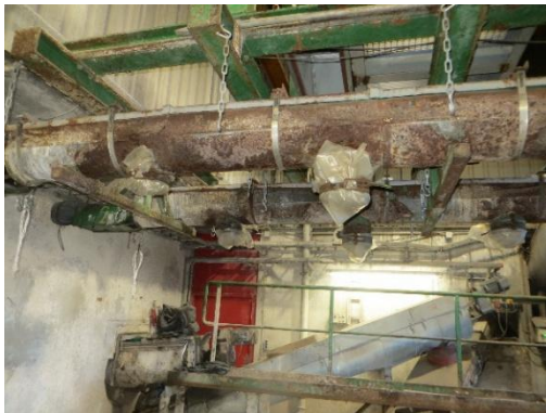
Området til udtag af restprodukter med det gamle udmadningssystem, som Nordværk ønsker at beholde.
