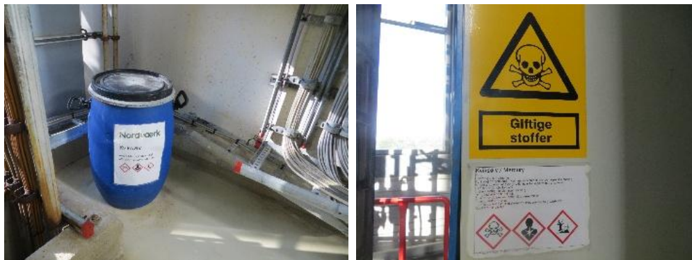
Opsamling af kviksølvholdigt materiale i forbindelse med aftapning af metalisk kviksølv fra ammoniakstripperen. Affaldet var opbevaret forsvarligt og mærket med faremærkning.
