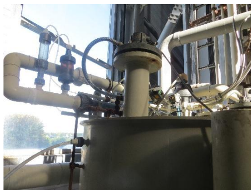
Blandetank for rensset spildevand til direkte udledning.
