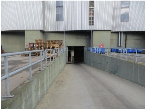
Nedkørsel til slaggekælder hvor der generelt ikke transport af slagge. Belægningen er i god stand.
