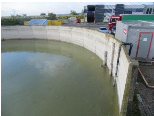
Spildevandstank vandet anvendes til røggasrensning.
