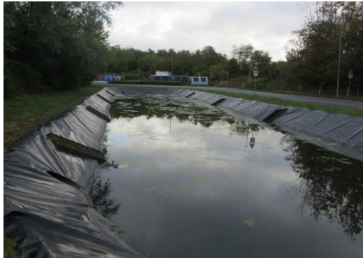
Bassin til opsamling af overfladevand. Ved udløbet sidder et gitter, der stopper større emner og nedfald, der er havnet i bassinet Udløb sker via udløbsbrønd til vandløbet, Banegrøften.
