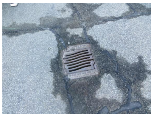
Ok repareret belægning ved afløb ved gamle udtag af restprodukter anlæglinje 3.
