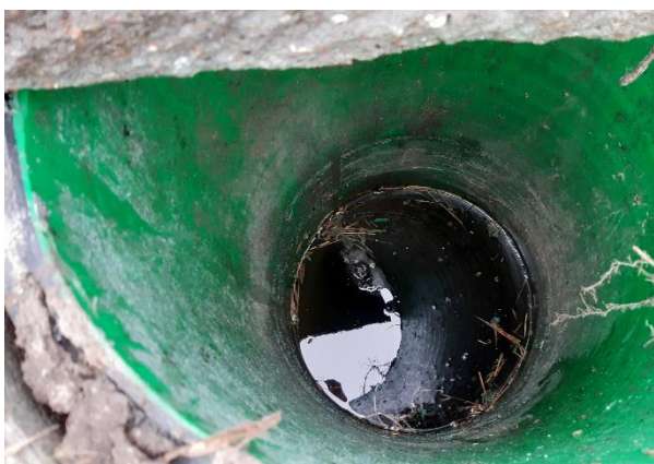
Figur 3. Inspektionsbrønde. Øverst: Inspektionsbrønde på midten af pladsen langs den sydvestvendte vold. Pumpebrønd ses i forgrunden. Midterst tv: Kig ned i pumpebrønd. Midterst th: gennemløbsbrønde, øvre dræn forrest, nedre dræn bagerst. Nederst tv: Samlebrønd for nedre dræn med, hvad der ligner en død rotte. Nederst th: Låget på brønden var knækket.
