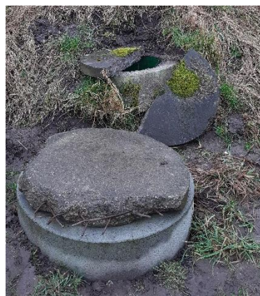
Figur 3. Inspektionsbrønde. Øverst: Inspektionsbrønde på midten af pladsen langs den sydvestvendte vold. Pumpebrønd ses i forgrunden. Midterst tv: Kig ned i pumpebrønd. Midterst th: gennemløbsbrønde, øvre dræn forrest, nedre dræn bagerst. Nederst tv: Samlebrønd for nedre dræn med, hvad der ligner en død rotte. Nederst th: Låget på brønden var knækket.
