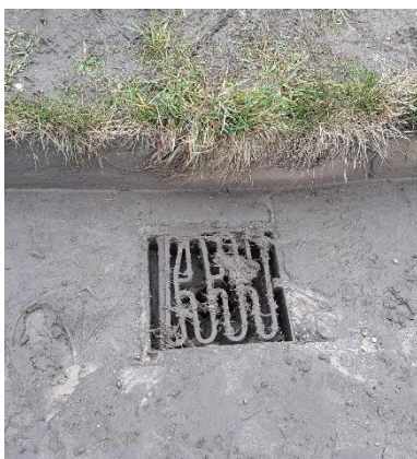
Figur 6. Problemer med stoppet afløb. Til venstre: Rist til afløb for afstrømmende overfladevand. Til højre: Betonrør er blevet placeret mellem jordbunkerne og afløbet for at fange det afstrømmende sediment.
