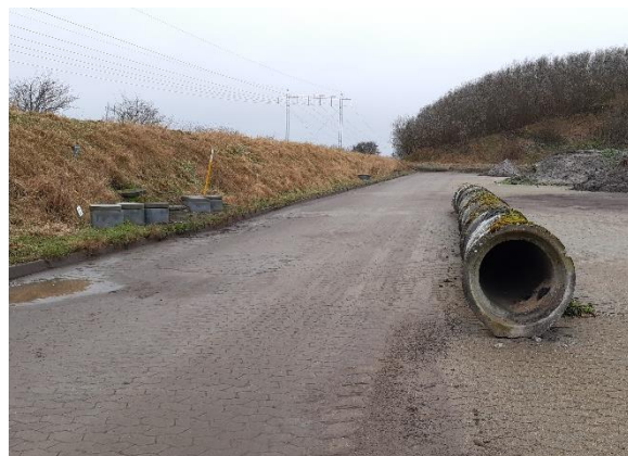
Figur 6. Problemer med stoppet afløb. Til venstre: Rist til afløb for afstrømmende overfladevand. Til højre: Betonrør er blevet placeret mellem jordbunkerne og afløbet for at fange det afstrømmende sediment.
