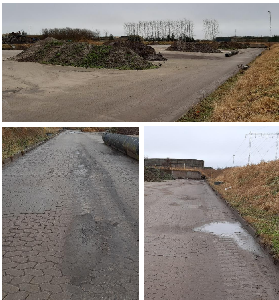
Figur 1. Jordbehandlingsplads. Øverst: Jordbunker på pladsen. Nederst tv: lunger i belægningen langs den nordøstvendte vold. Nederst th: lunger i belægningen langs den sydvestvendte vold.
