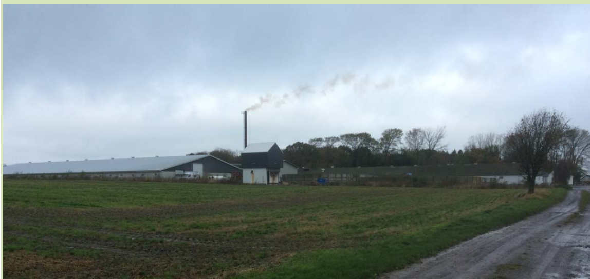
Foto taget den 1/11-17 af Gillesbjergvej 10, set fra syd. Til venstre stald og nyt halmfyr, og de eksisterende gyllebeholdere, der ligger lavt i terrænet midtfor og til højre. Den nye beholder ønskes opført ca. midt i billedet.
