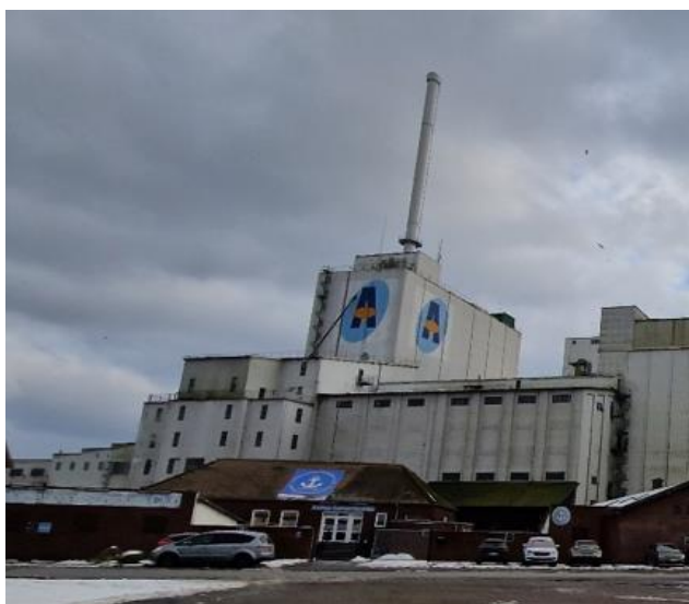
Den nye skorstens (fællesafkast)
