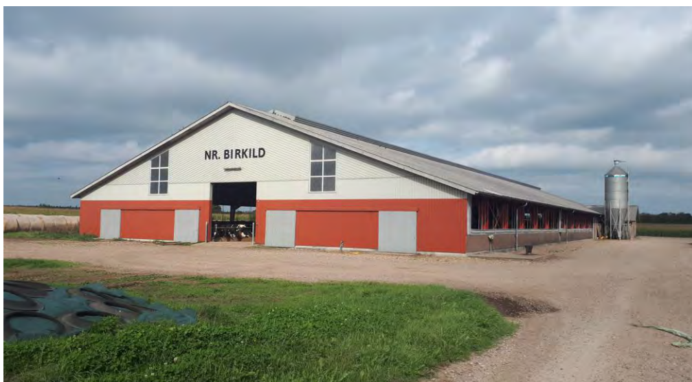
Figur 4.1.1. Den eksisterende kostald set fra syd.
