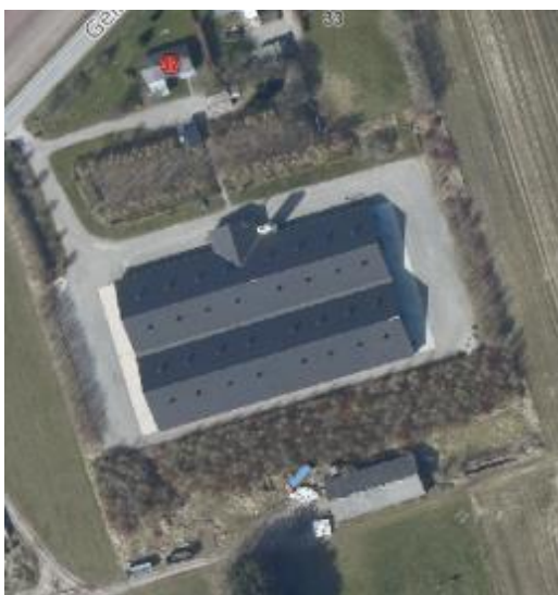
Figur 1. Oversigt over bygninger.
