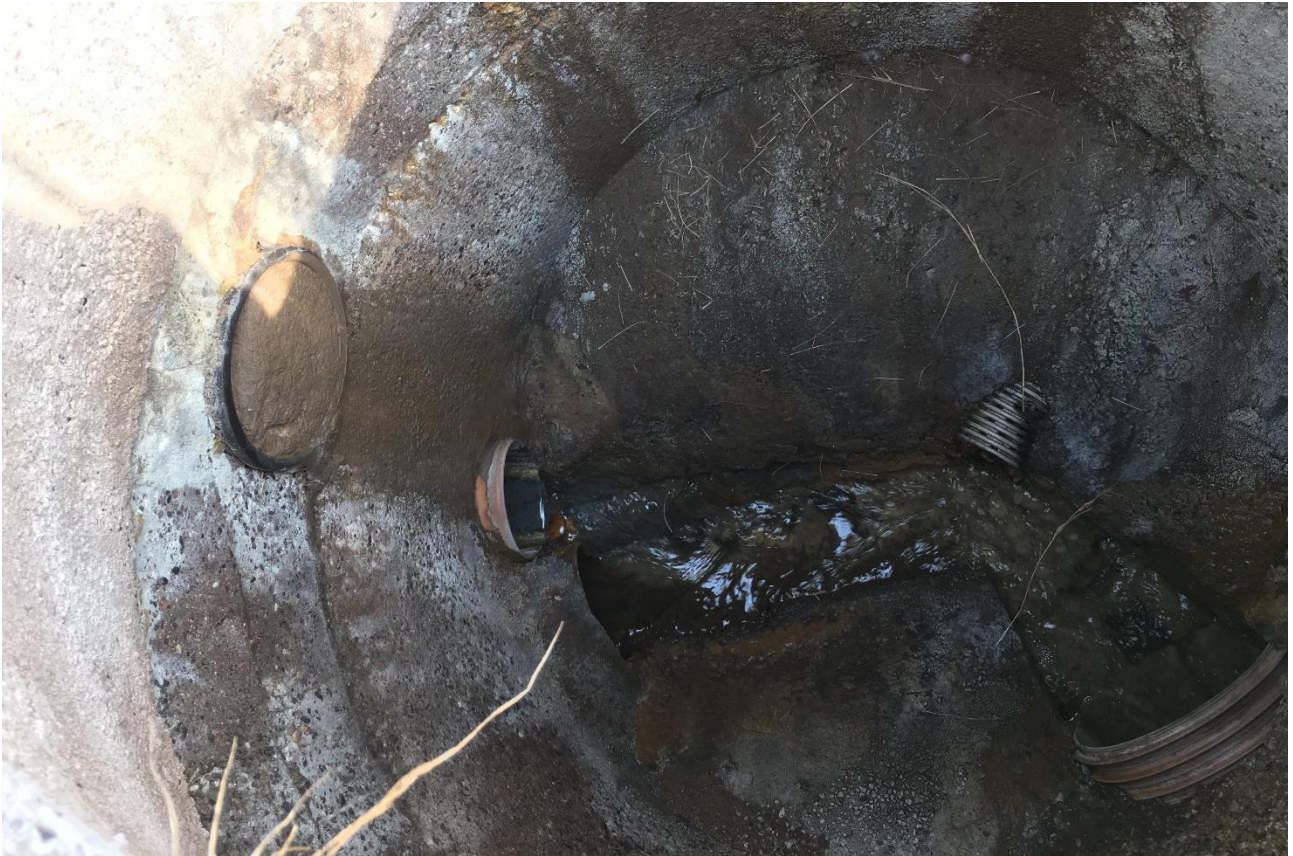
Brønd før åbning for rodzoneanlægget
