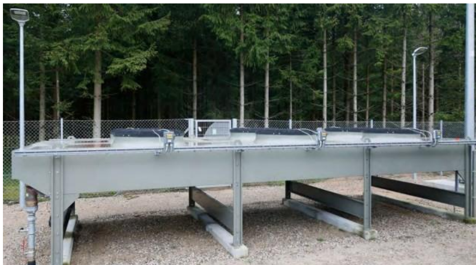
Figur 4 - Køler til kompressorer.
