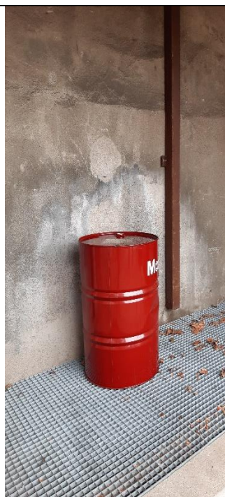
Foto 2: Opbevaring af olieprodukter på spildbakke. Der er ikke afløb i rummet.
