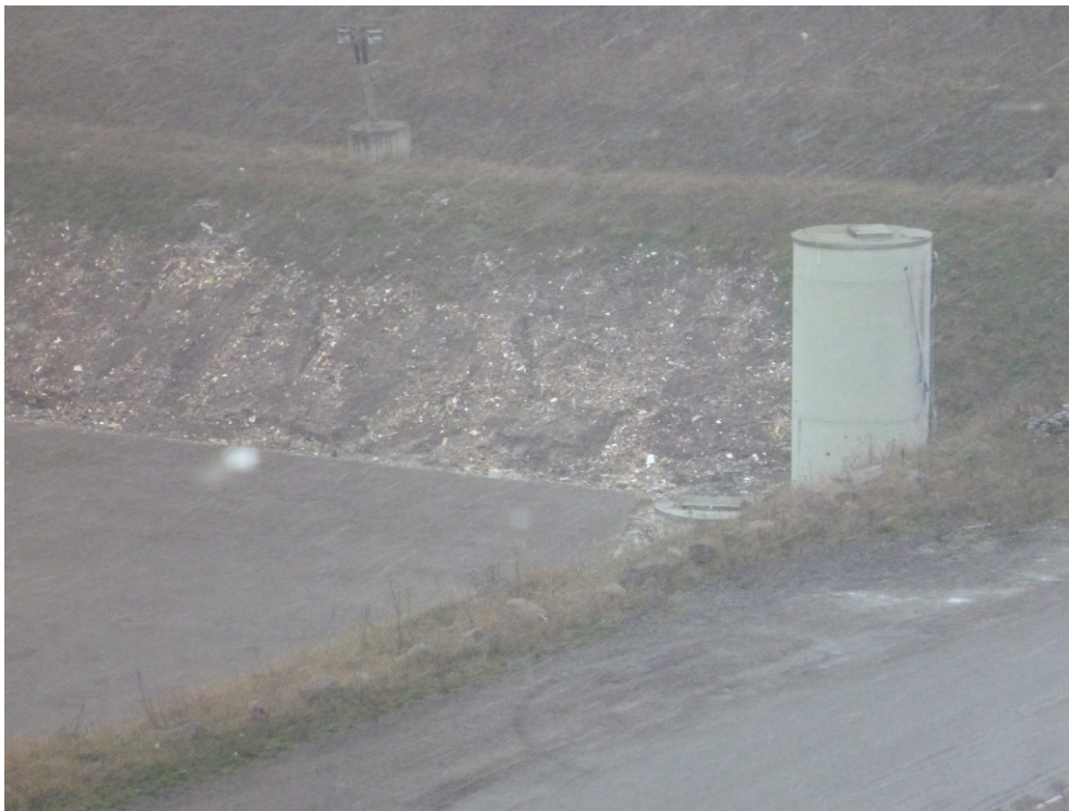
Foto. Oplagsplads for mellemoplæg til forbrændingseget affald. Oplagspladsen var på tilsynet tømt for forbrændingseget affald. Til højre ses en perkolatbrønd.
