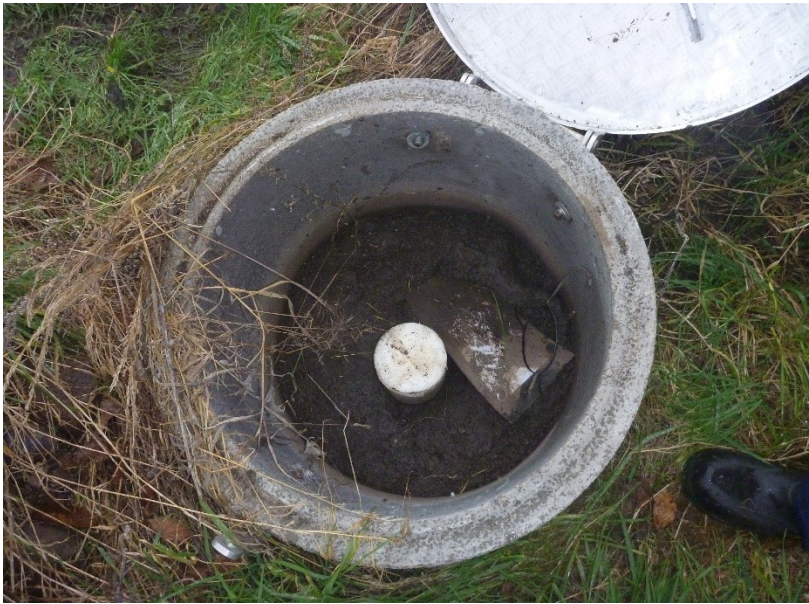
Foto: Grundvandsboring til overvågning.
