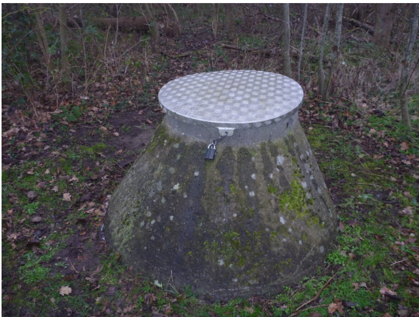
Foto: Aflåst dæksel, grundvandsboring uden for depotet mod vest.
