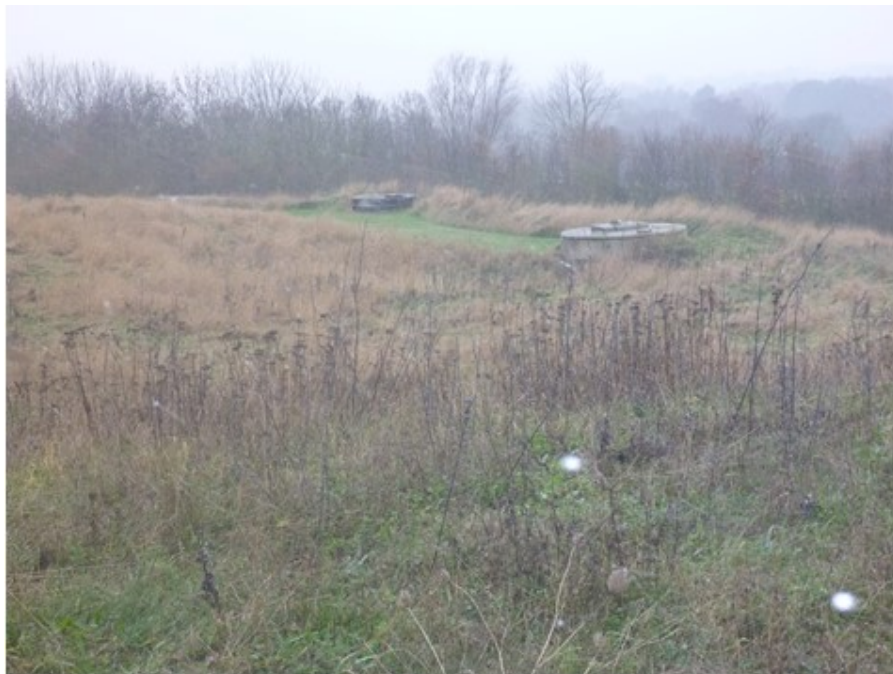
Foto: Slutafdækket deponienhed. Der ses toppen af to perkolatbrønde.
