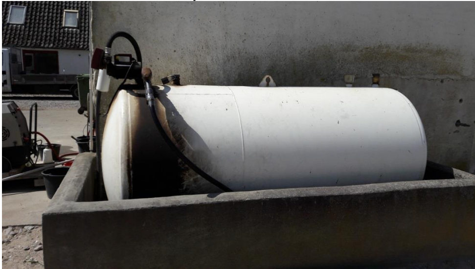
Figur 3 Dieseltank fra 2010. Tanken er placeret ved siden af vaskepladsen i en grube.
