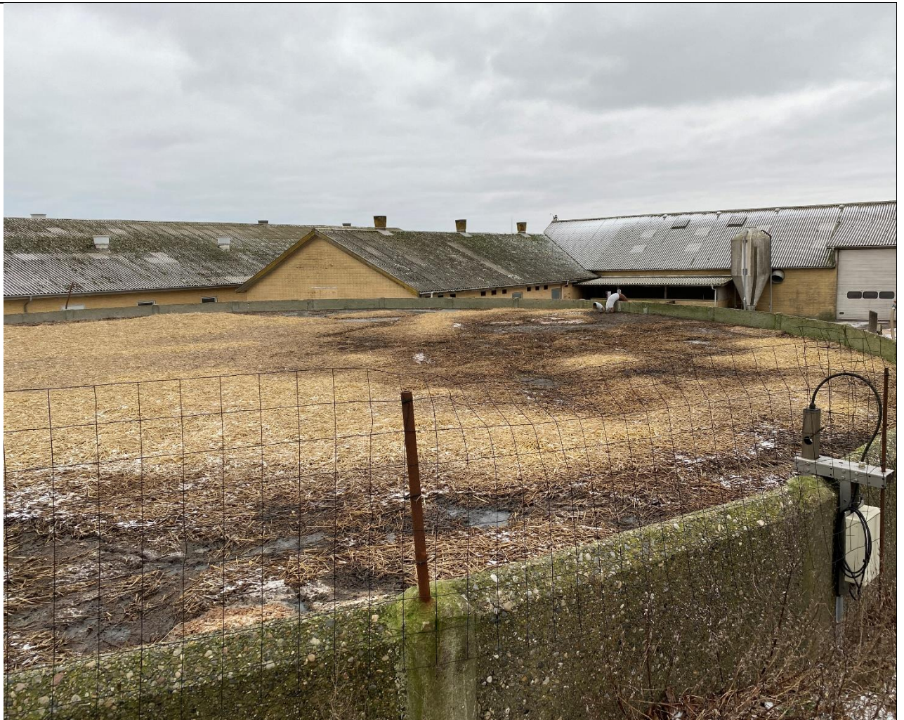
Risiko for overfyldt gyllebeholder?
