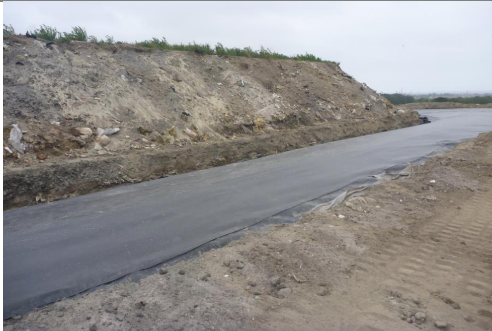
Foto 2. Foto er taget i vestlig retning af den færdige sammensvejsning ny og gamle membraner.
