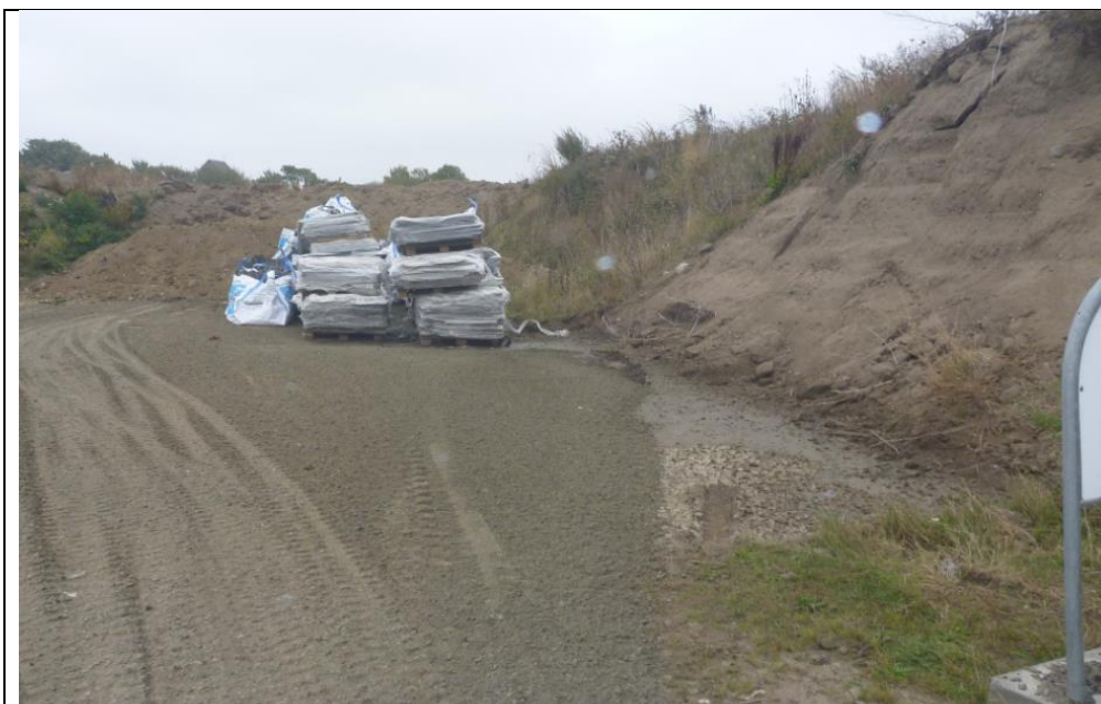
Foto 14. Indpakket asbestholdig eternit.
