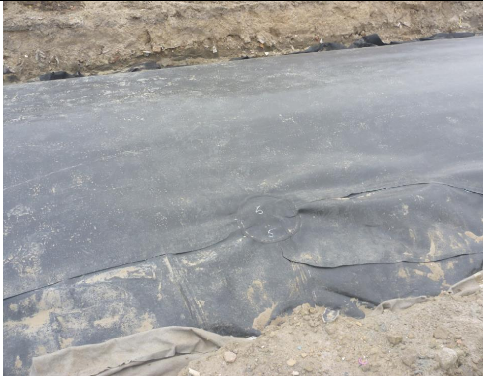
Foto 10. Udbedring af eksisterende membran fra enhed A.
