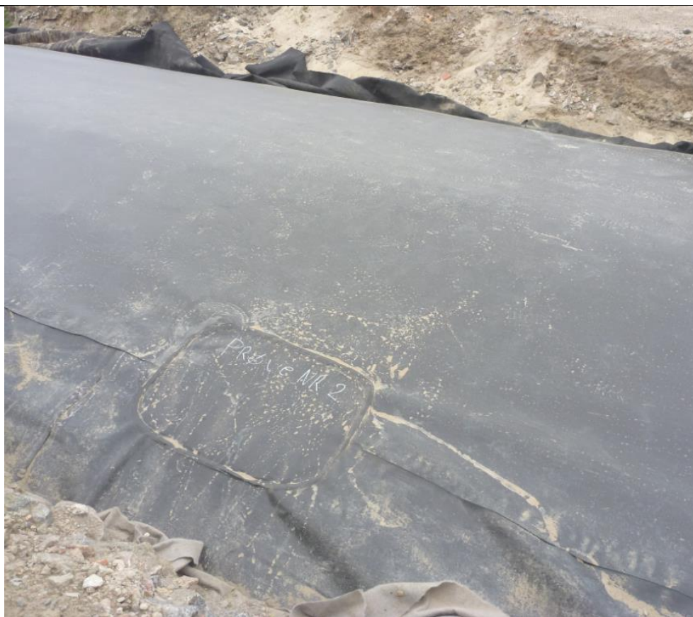
Foto 11. Reparation af område hvor der er udtaget prøve til brug for forskydnings- og skrælningstest af sammensvejsning mellem den nye membran og den eksisterende membran fra enhed A.
