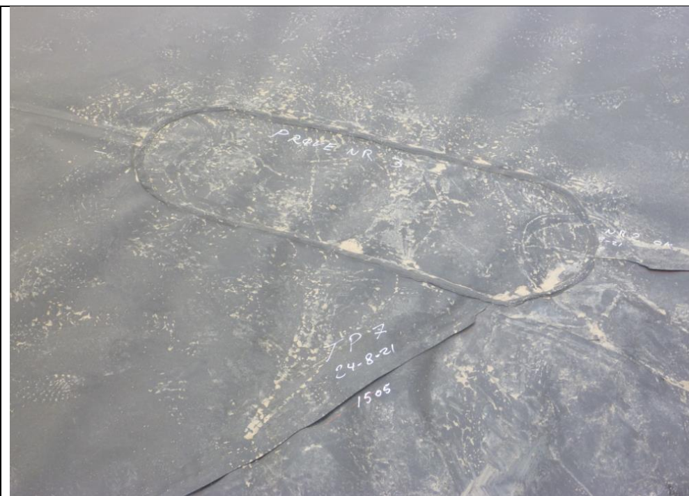
Foto 12. Reparation af område hvor der er udtaget prøve til brug for forskydnings- og skrælningstest. Desuden ses påtegninger fra svejseoperatør. Står TP7 står for trykprøve 7?
