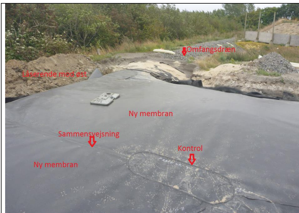
Foto 6. Foto af låserenden ved enhed C mod Almegårdsvej. Det eksisterende omfangsdræn ses samt området for svejseprøve mellem nye membraner.
