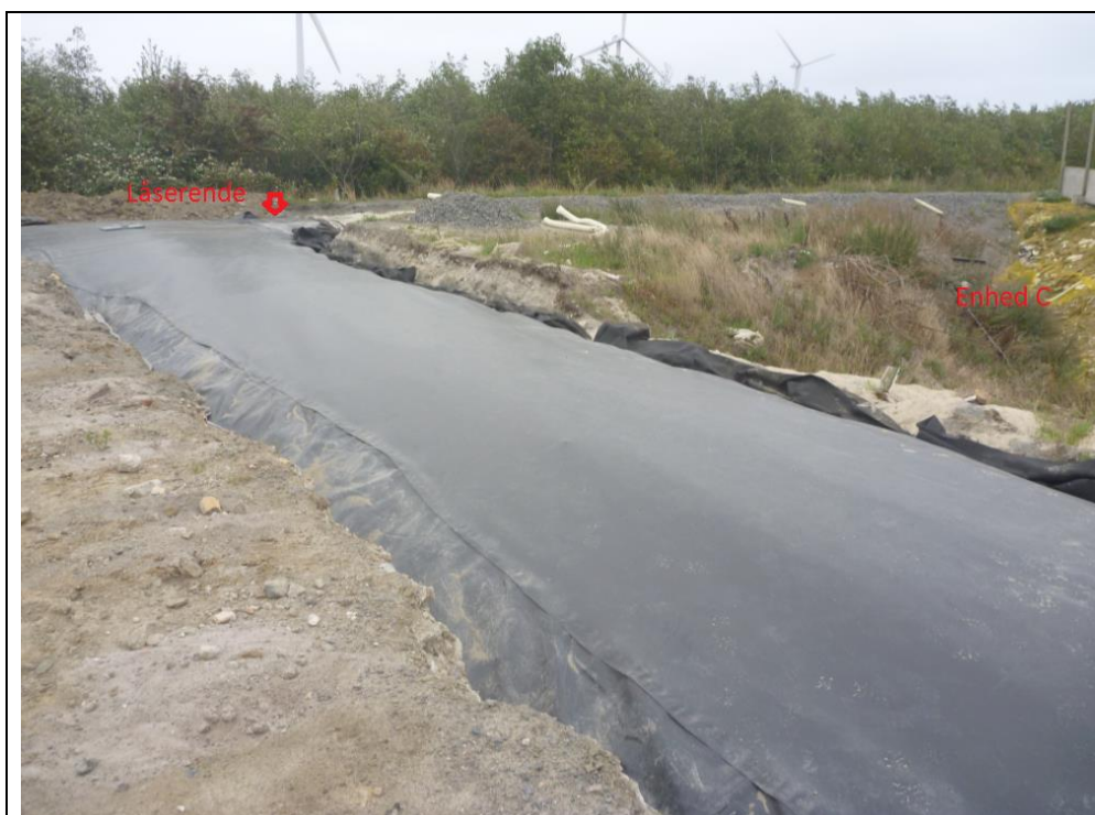
Foto 4. Foto af den færdige membran taget i retning mod Almegårdsvej. Sammen svejsningen mellem ny membran og membran fra enhed A ses.
