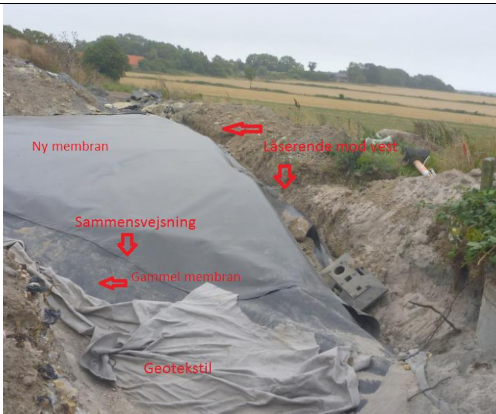
Foto 3. Låserenden mod vest. Den eksisterende geotekstil fra enhed A ses nederst på billedet.
