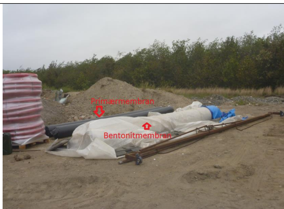
Foto 13. Rest af plastmembran og indpakket Bentonitmåtte .
