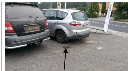
Billede nr. 7: Regnvandsrist
