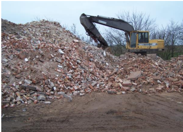
Alm. byggeaffald til nedknusning - gravemaskine
