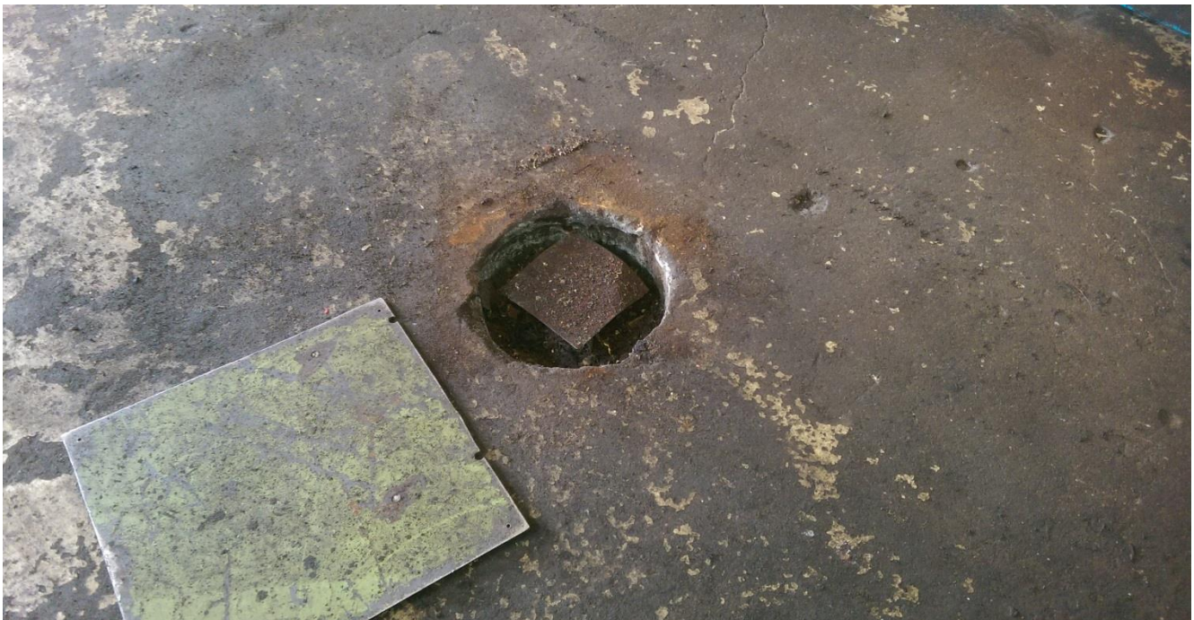
Prøvetagningsboring i værkstedsgulv.
