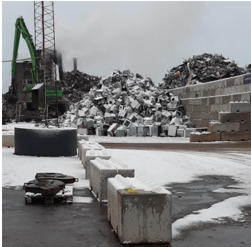
Betonklodser som støjmur
