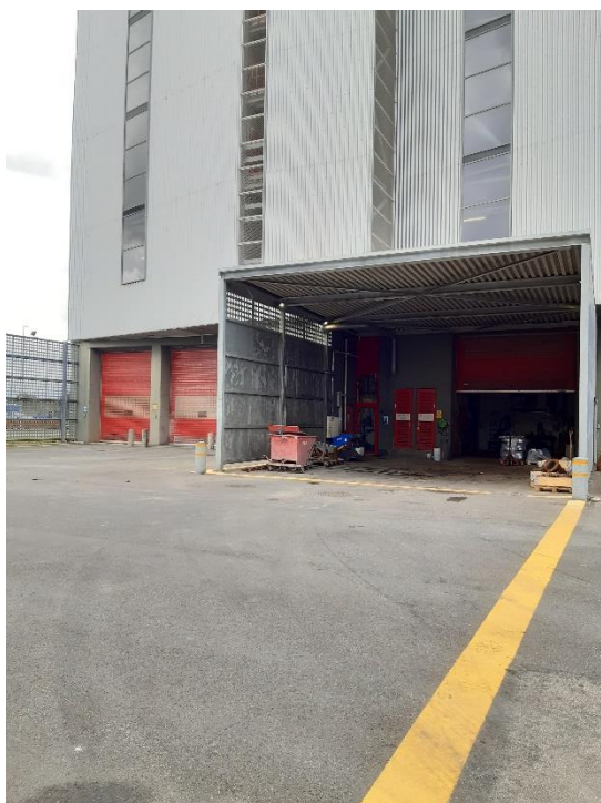
Foto 3. Til højre: Vaskeplads. Til venstre: Oplagsplads til restprodukter fra røgrensning på Ovn 3.
