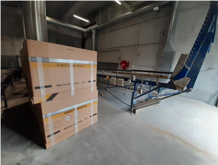
Foto 4: Modtagehal med transportbånd til automatisk håndtering og indfyring af klinisk risikoaffald.
