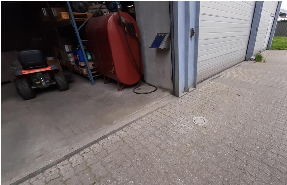
Foto 3. Belægning ved virksomhedens dieselolietank. Boring fra BTR ses i forgrunden
