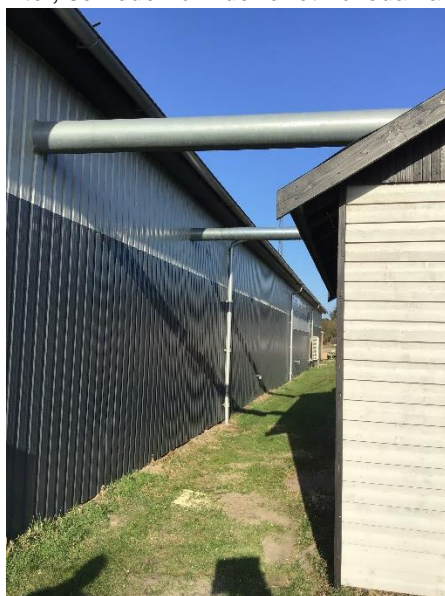
Ovenstående spåneudsug kører sammen ud i en bygning, hvor de har hvert sit filter, se nedenfor - der er ét hovedafkast fra de to udsug.
