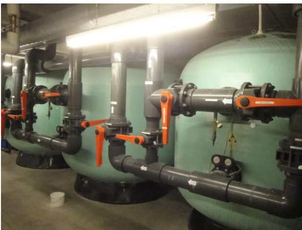
3 tryksandfiltre (Ø2350 mm) til filtrering af bassin vandet. Chlor-elektrolyse anlægget.
