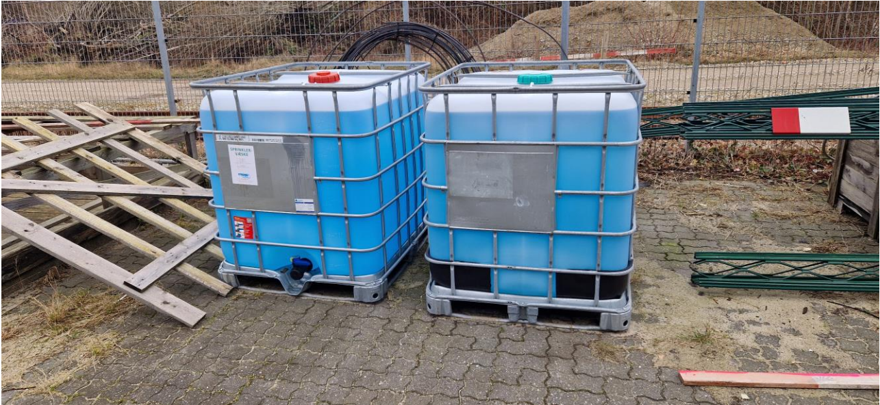
Sprinklervæske opbevares uden spildsikring.
