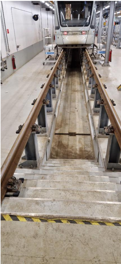
Værkstedsglav med gulvafløb.
