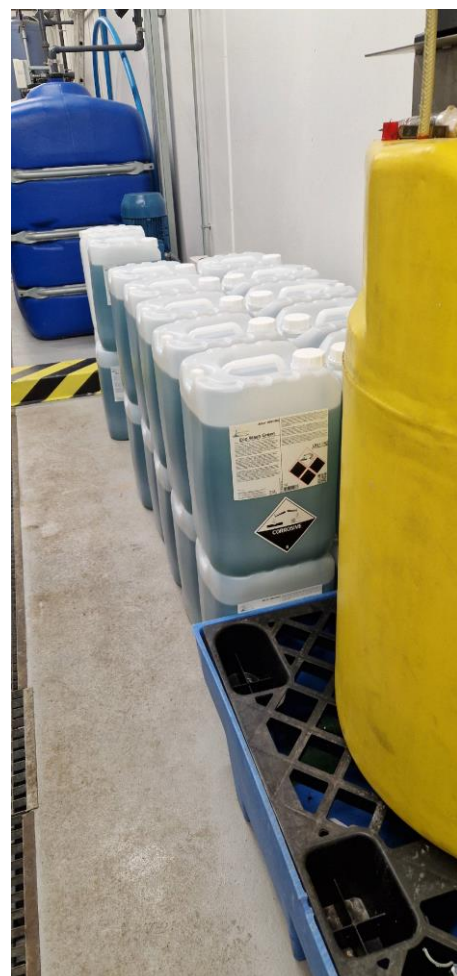
Vaskekemi uden spildsikring.
