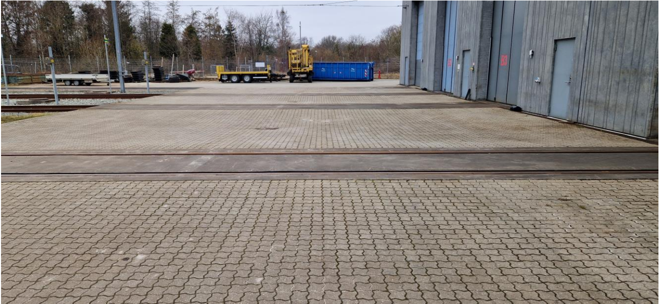
Arealet, hvor der foretages vask af togenes hjul/undervogn forud for service på værkstedet.
