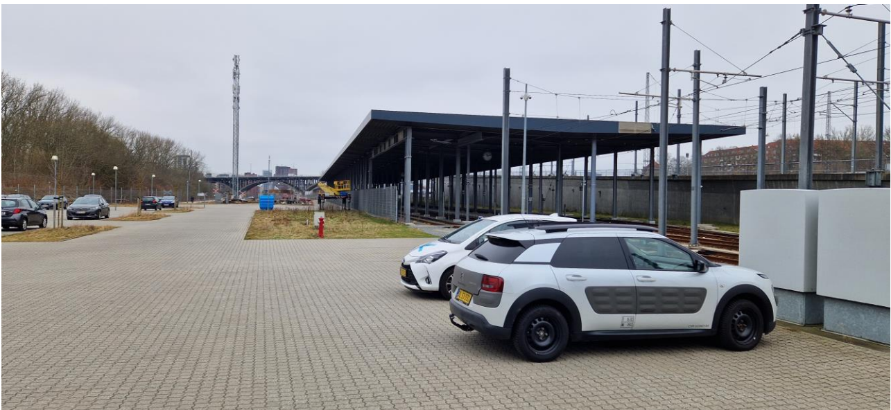
Til togvask anvendes opsamlet tagvand fra denne overdækning, som benyttes til natopbevaring af tog. Vandet opbevares i en nedgravet tank.
