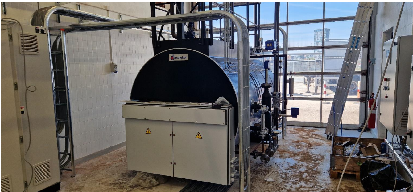
Nyt el-kedelanlæg under opførsel.
