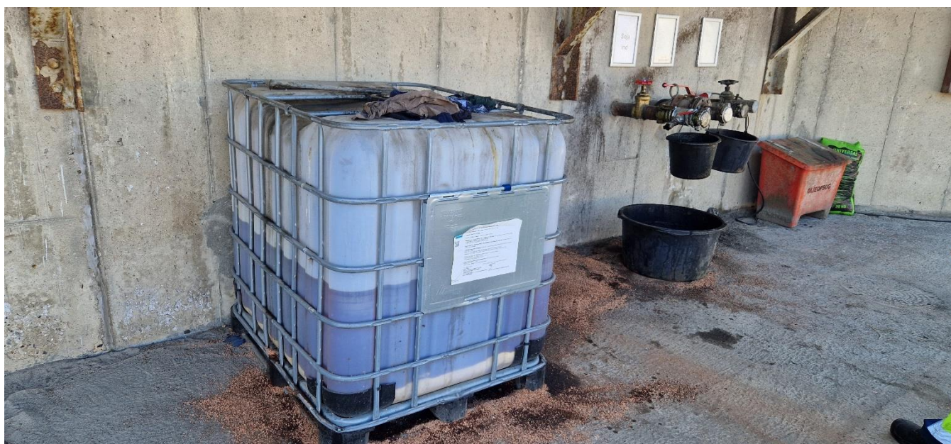
Soyaolie i palletank uden spildsikring ved indpumpningsanlægget ud mod Bahreinvej. Palletanken bruges til at fylde rester fra påfyldningsslangere over i.
