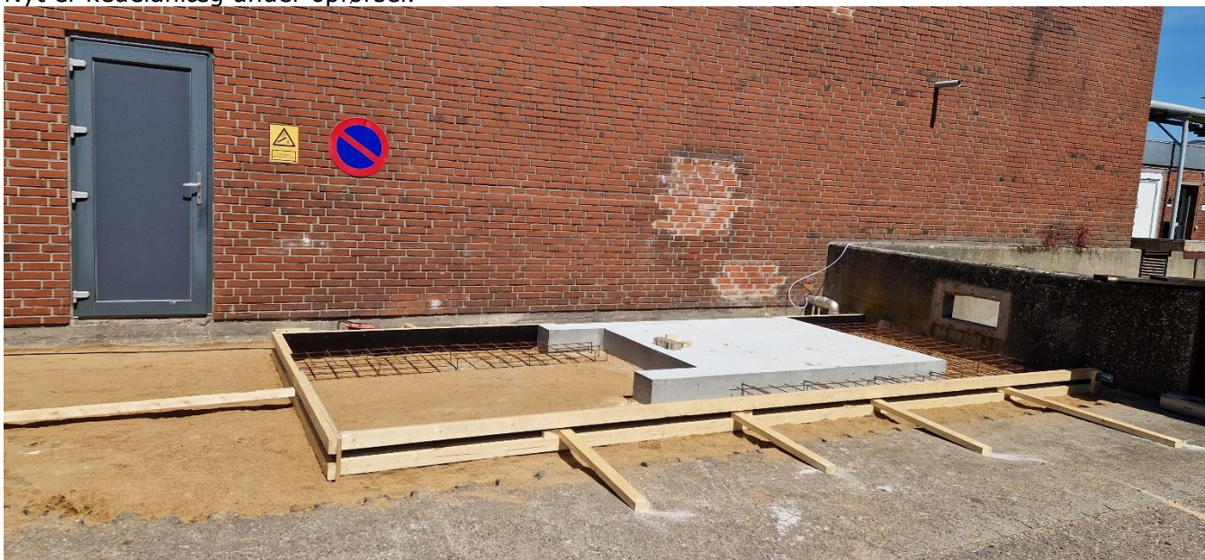
Etablering af elforsyning til nyt el-kedelanlæg. Etableres ved den tidligere vaskeplads.
