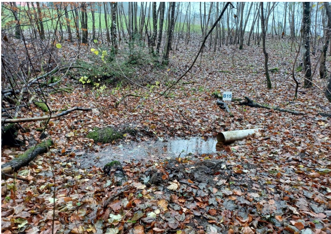
Figur 6. Udledning af overfladevand fra Affaldscenter Skårup i skovbunden nordvest for anlægget.
