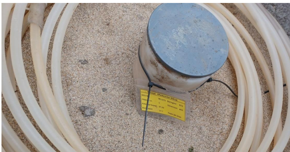
Figur 10. Boring B23 (DGU 98.1372). Øverst: Overbygning. Nederst: Nyt forerør \varnothing 100 mm med gammel mærkat.
