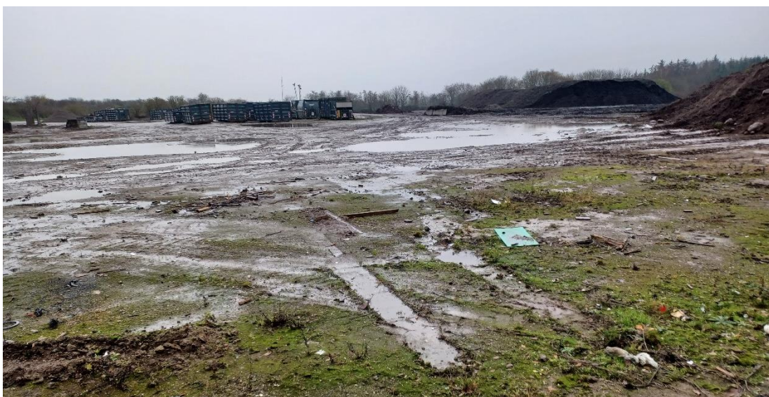
Figur 2. Afvikling af affaldsbehandlingsaktiviteter. Øverst: Etape 3A, oplag af trykimprægneret træ mv er fjernet. Midt: Etape 2.1, vand på pladsen ved oplag af metalaffald. Nederst: Etape 1, 2.1 og 2.2, de fleste oplag er fjernet fra komposteringspladsen.
