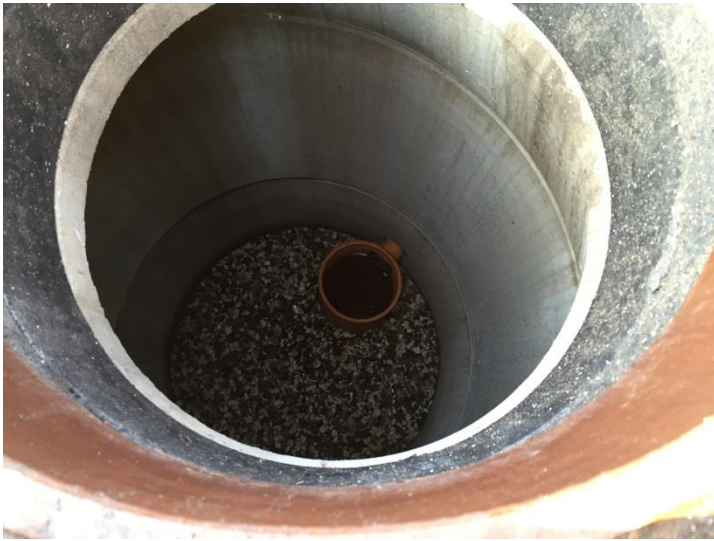
Billede 3 – prøvetagningsbrønd efter olieudskiller
