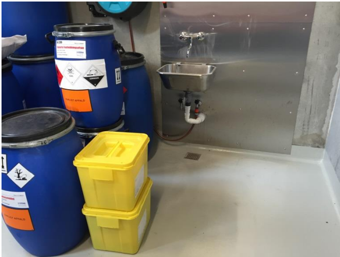
Billede 1 – afløb til nedsvivningsanlæg
