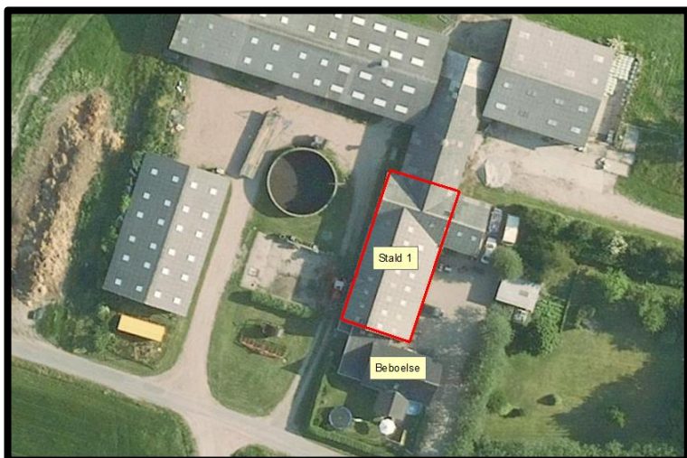
Figur 3. Manglende overholdelse af afstandskrav.
