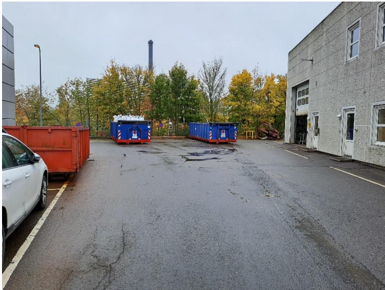
Opbevaringsplads for restprodukter fra røggasrensning og kedelaske
