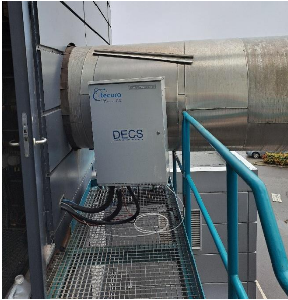
Dioxinmåler på røggasrøret på ovn 3
