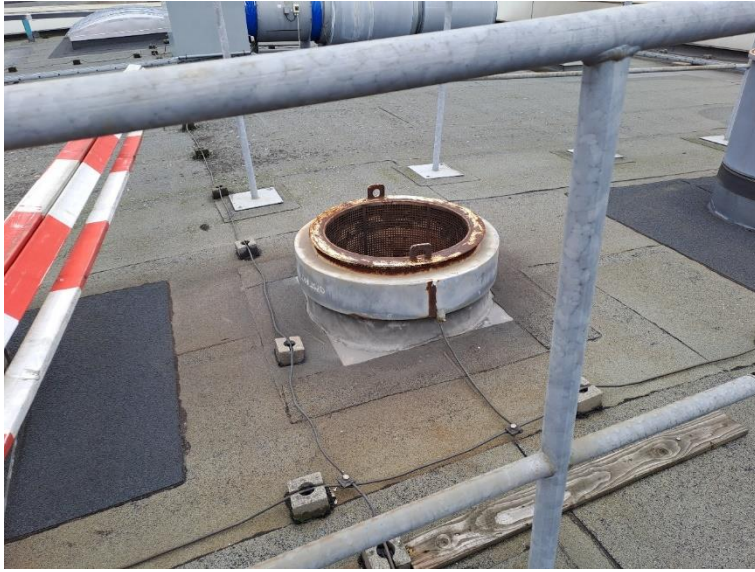
Opstartsventilens afkast på tag
