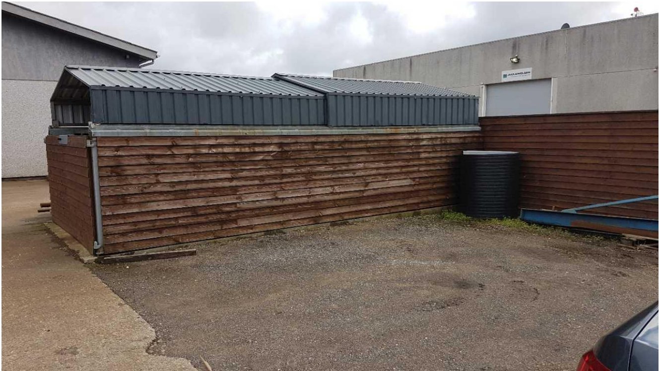
Overdækket spåncontainer med opsamlingssump under containeren.
