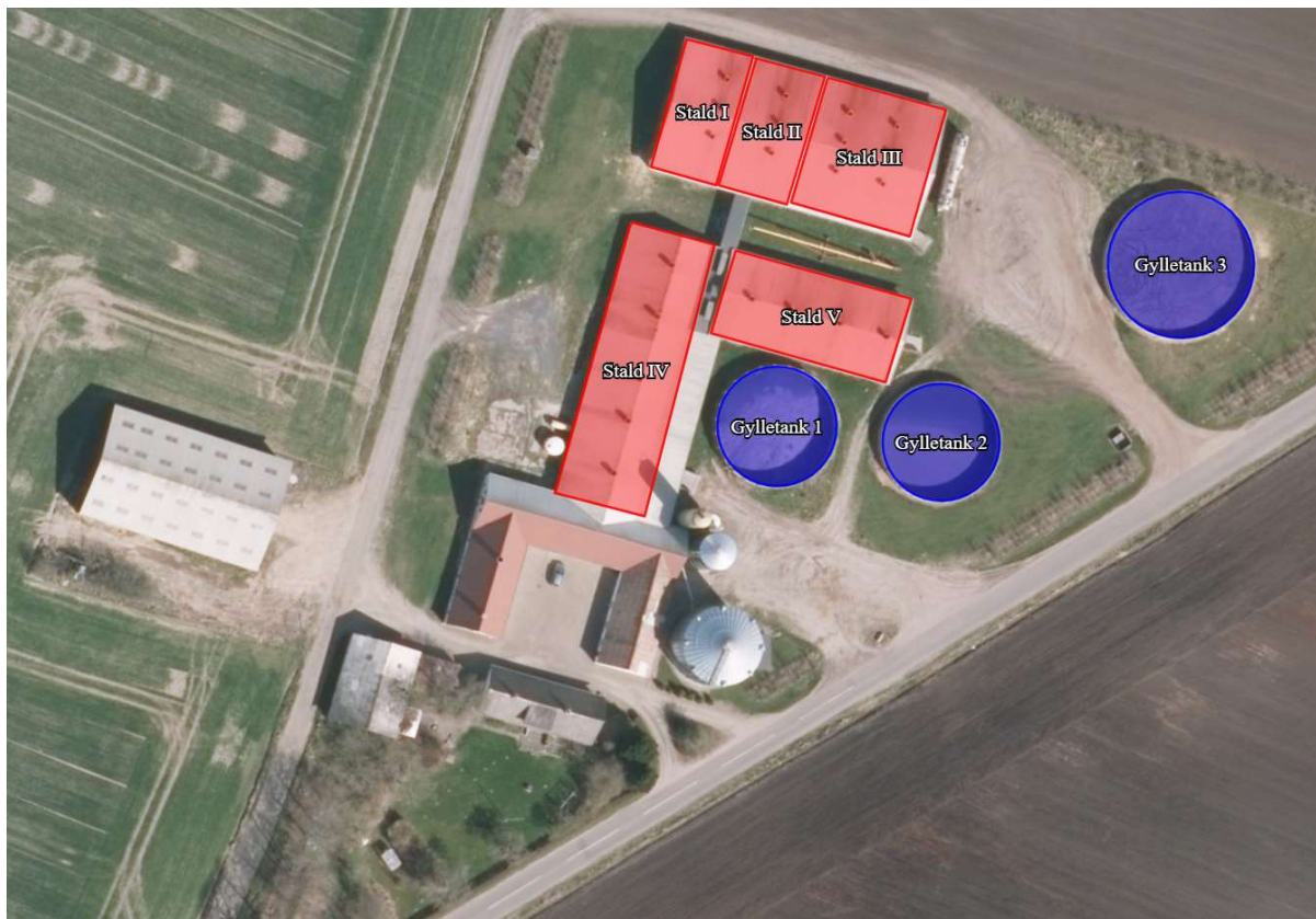
Bygningssætterne tilhørende Sønderbjergvej 15, 7400 Herning.
