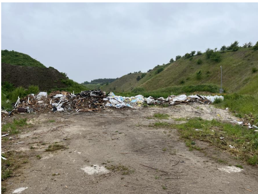
Figur 4 Manglende daglig afdækning af flanker og front med jord eller grus ved PCB enheden/cellen.
