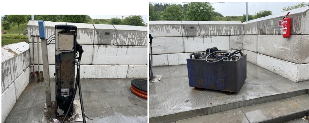
Figur 14 Betonplads med tankstander og mobil dieseltank til kompaktoren.
