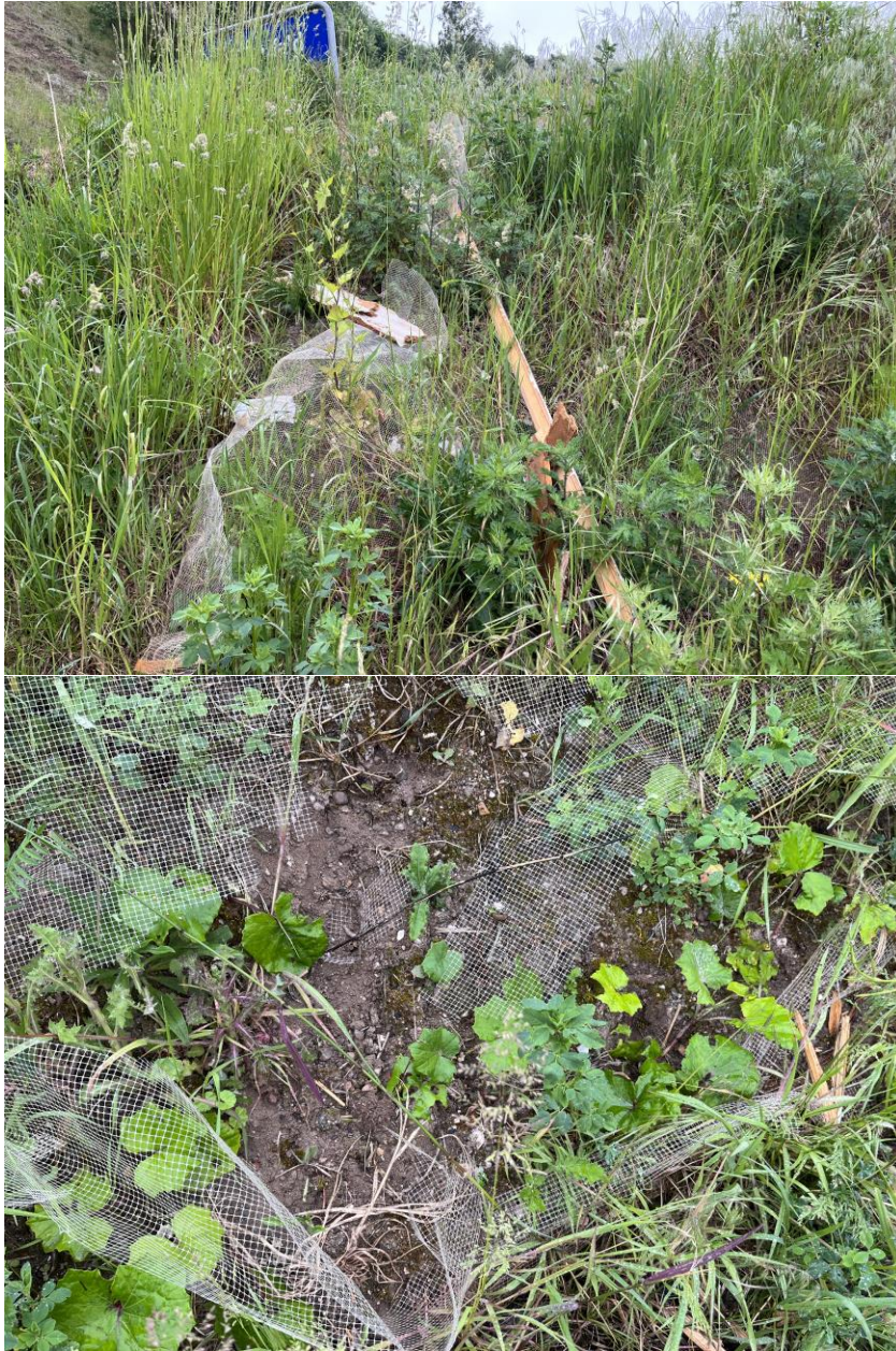
Figur 3 Eksempler på defekt markeringsnet. Der var flere steder, hvor markeringsnettet ikke var til stede, da det var i stykker.
