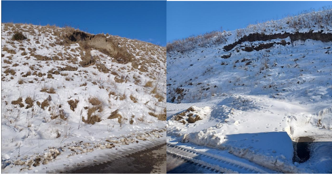
Venstres side: Skred i etape 6.2. Højre side: Skred i etape 6.1
