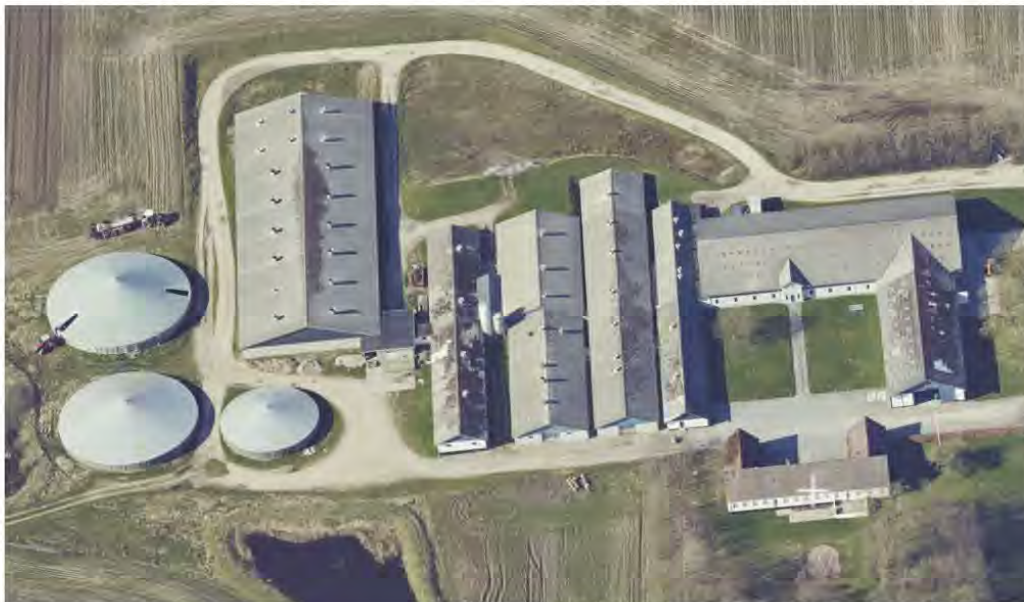
Bygningsstil på de eksisterende staldafsnit fra syd
