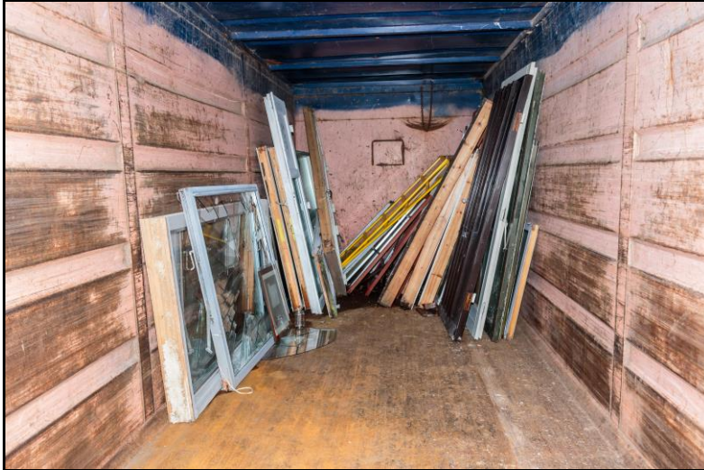
Foto 1 Aktuel opbevaring, i lukket container, af potentielt PCB-holdige vinduesrammer med glas.
