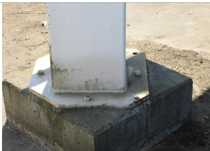
5. Stålbene står på punktfundamenter.
