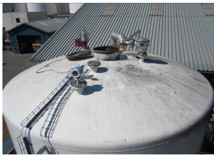
12. Taget med studse set fra lift.
