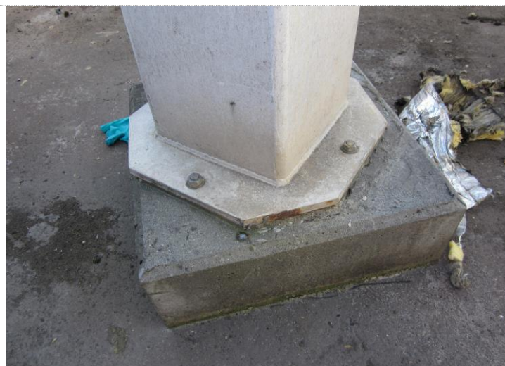
3. Stålbene står på punktfundamenter.
