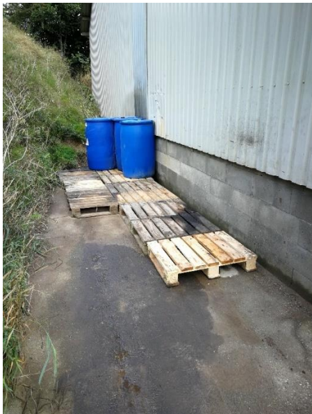
Tønder med spildolie placeret udendørs på støbt plads med afløb til nedgravet opsamlingstank.
