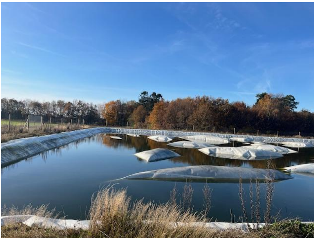
Lagunen med regnvand ovenpå coveret
