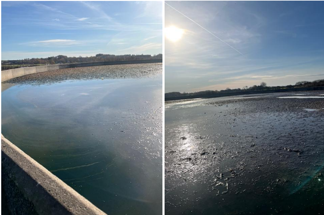
Gylletank med mangelfuldt flydelag. November 2025
