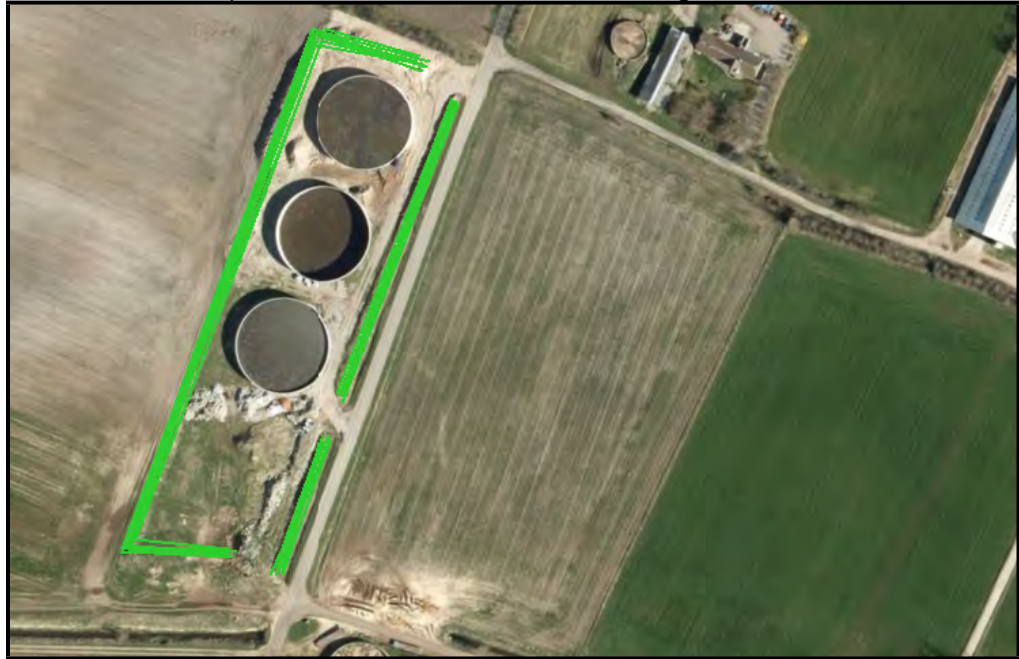
Figur 3: Placering af afskærmende beplantning omkring beholderne og møddingsplads ved Vestermarksvej 4.
