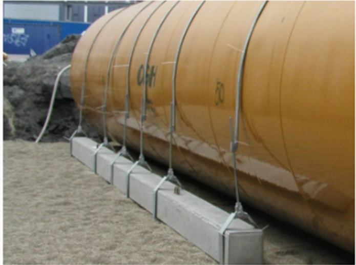
Tank etableret på komprimeret grus pude med betonbjælker
