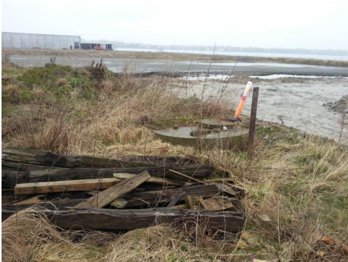
Foto 8: Overløbsbygværket, set mod nord-nordvest.
