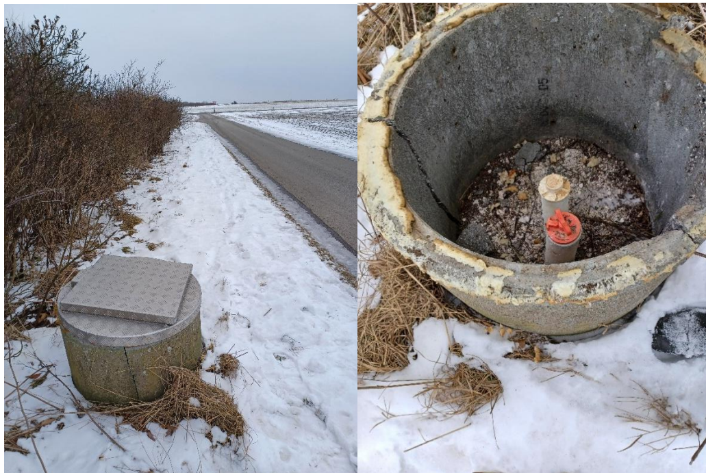
Fotosamling 1. Grundvandsboring ved Stokhøjvej mod syd.
