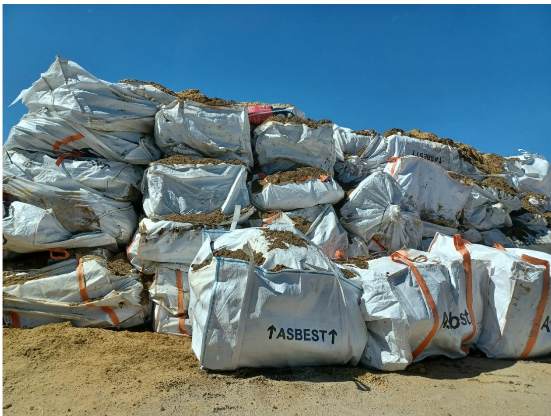
Figur 4: Ikke afdækket asbest indpakket i big bags
