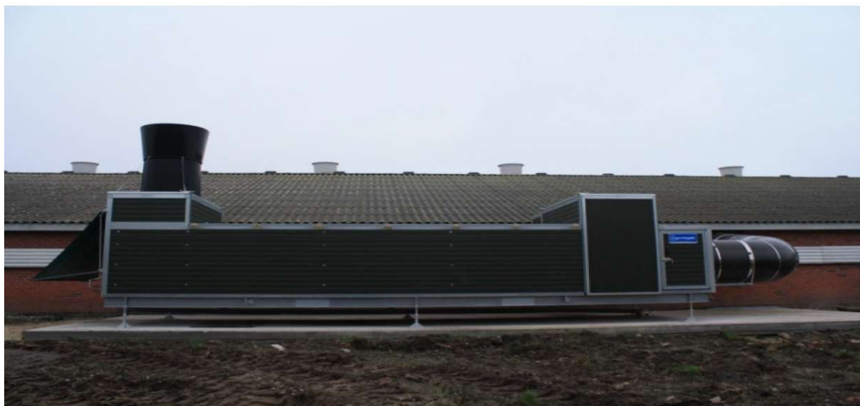
Figur: Varmeveksler opstillet uden for kyllingestald. Gengivet med tilladelse fra Rokkedahl.
