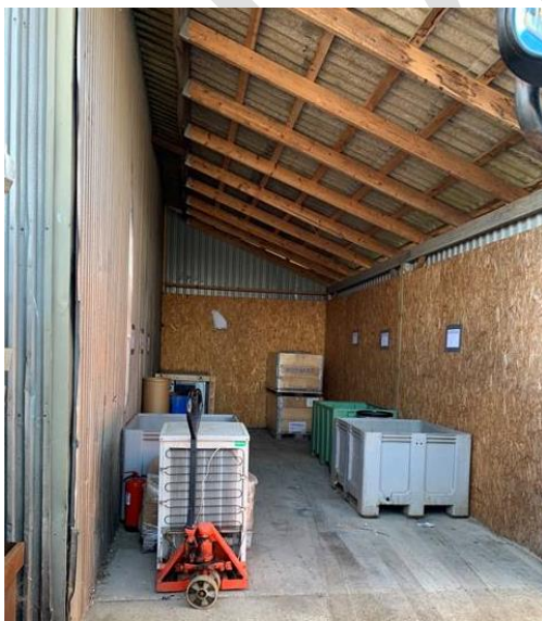
Opbevaringsplads i den eksisterende hal, som skal indrettes til opbevaring af de afhentede containere til madaffald
