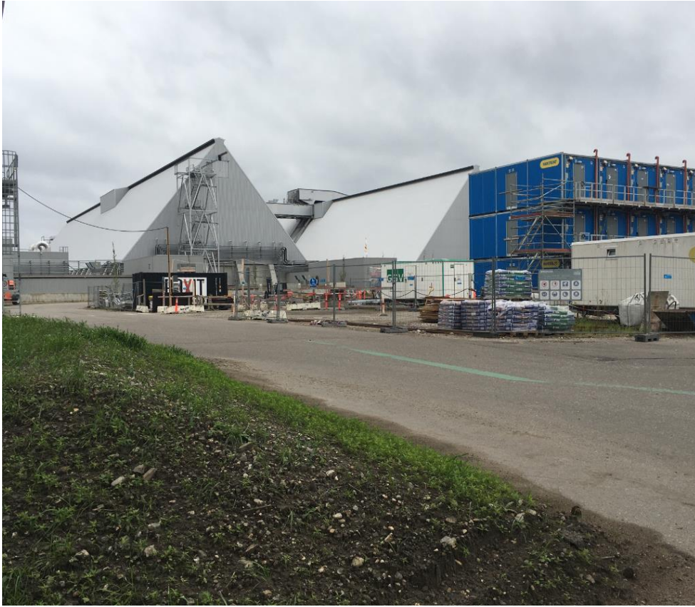
Foto 8 Nye lagerhaller til flis set mod øst
