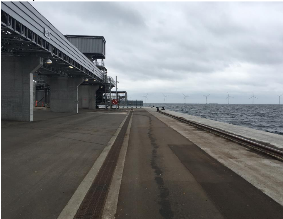
Foto 1 Betonkaj mod syd
