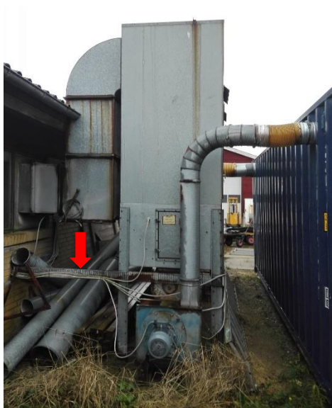
Spånsilo er udskiftet med container. Afkastet fra filteret er markeret med pil.
