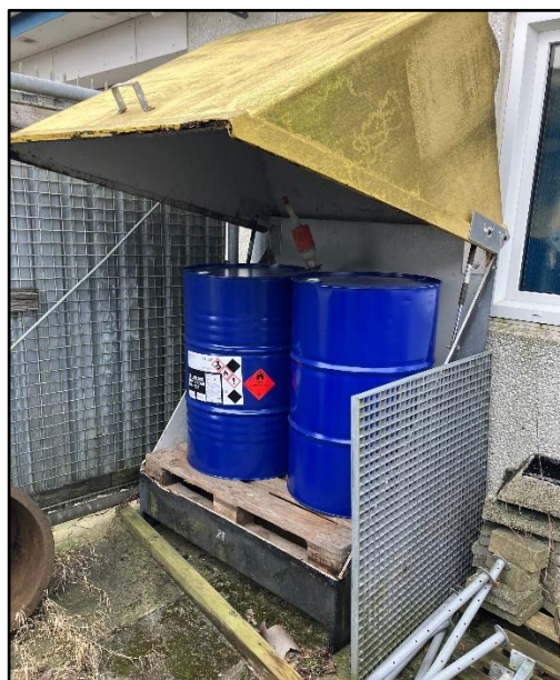
Fortynder udendørs på spildbakke med låg, der holdes lukket
