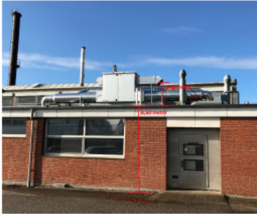
Figur 4.1: Placering af HEPA-filter og afkast (vandret).
