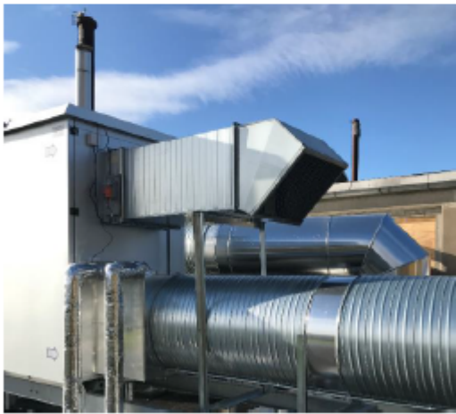
Figur 4.2: Nærbillede af afkast.
